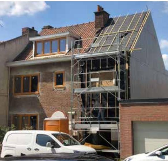
*L'isolation par l'extérieur de la façade en brique vient s'aligner sur l'extension, permettant de créer une façade homogène et respirante, garante d'une bonne pérennité du bâti.*
